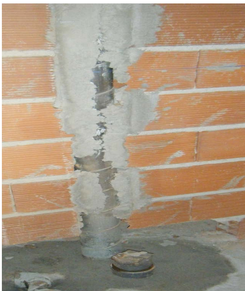
Figura 3.17. Exemplo de prumadas de ar a passar dentro das paredes.
