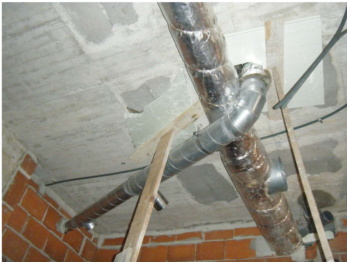
Figura 3.20. Cruzamento de condutas.
