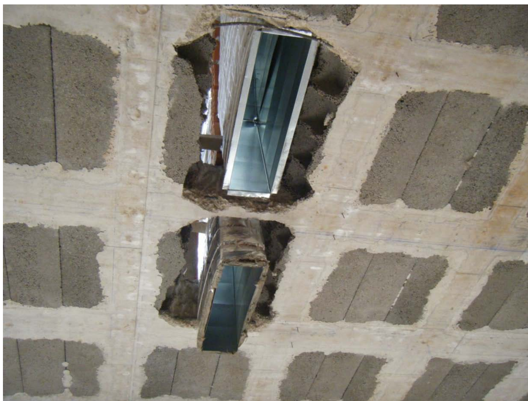
Figura 3.16. Exemplo de prumadas de condutas de ar a passar através de blocos de betão leve e embebidas em parede de tijolo.
