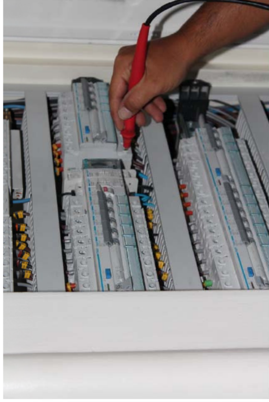
Verificação inicial das instalações elétricas – Inspeção visual e ensaios
