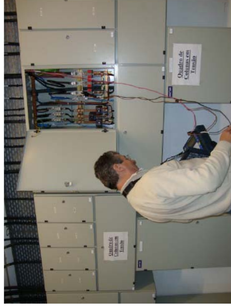
Verificação inicial das instalações elétricas – Inspeção visual e ensaios
