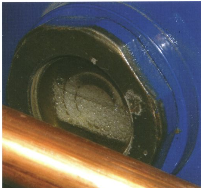
A espuma pode ser vista claramente no visor de líquido do compressor, o que é uma indicação clara da presença de refrigerante líquido no óleo.
