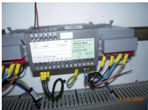
Figura 4. 14- Wattímetro do circuito de tomadas
