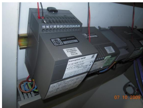
Figura 4. 15- Wattímetro do circuito de iluminação
