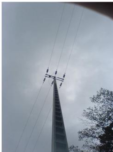
Figura 3.6 - Armação tipo esteira horizontal (HRSFC).
