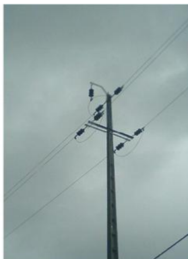
Figura 3.7 - Armação tipo triângulo para alinhamento (TAL).
