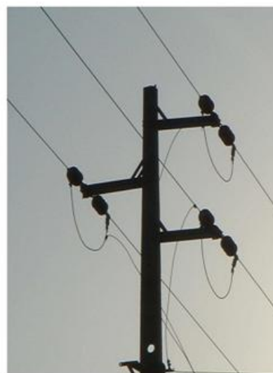
Figura 3.8 - Armação tipo galhardete para alinhamento (GAL).
