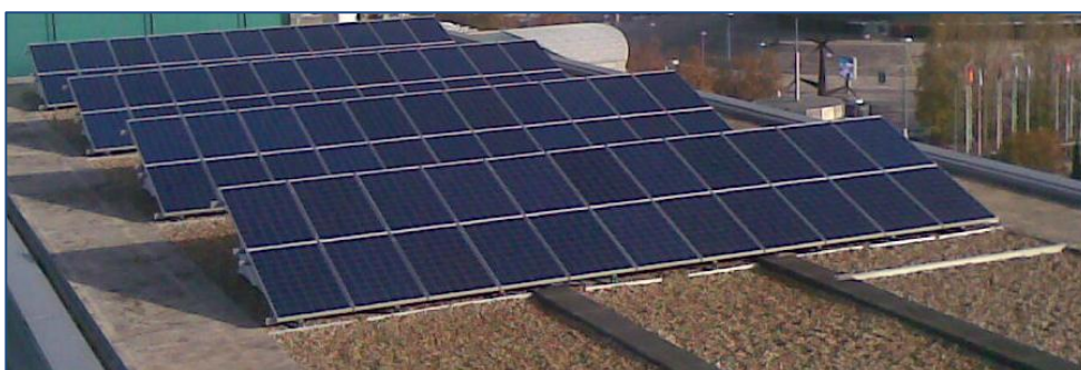
FIG. 36- MÓDULOS ESTABELECIDOS EM COBERTURA COM SOBREPOSIÇÃO
