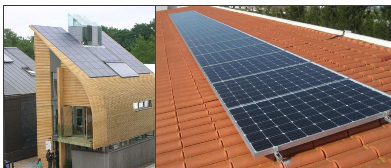
FIG. 34 - MÓDULOS ESTABELECIDOS EM TELhado INCLINADO
