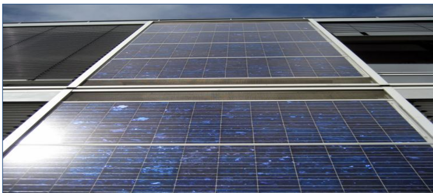
FIG. 37 – MÓDULOS ESTABELECIDOS EM FACHADA DE EDIFÍCIO
