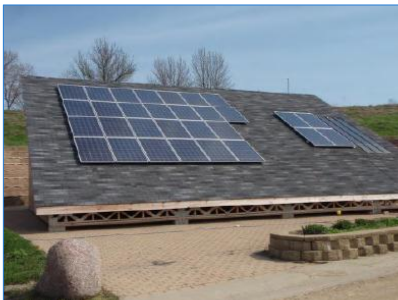
FIG. 46 - ESTRUTURA FV PARA ENSAIOS DE SEGURANÇA
