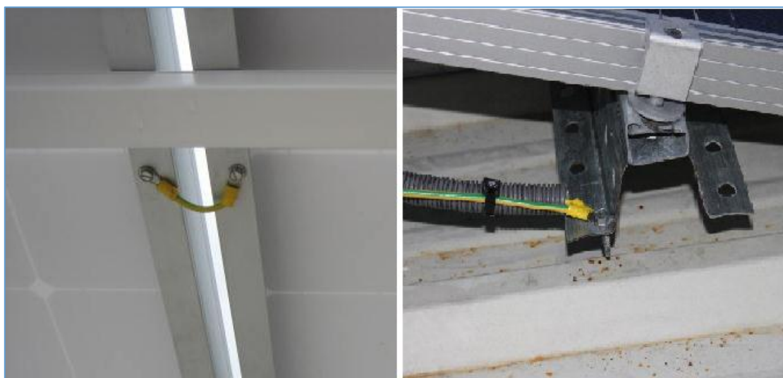
FIG. 28– LIGAÇÃO EQUIPOTENCIAL DE MÓDULOS FV
