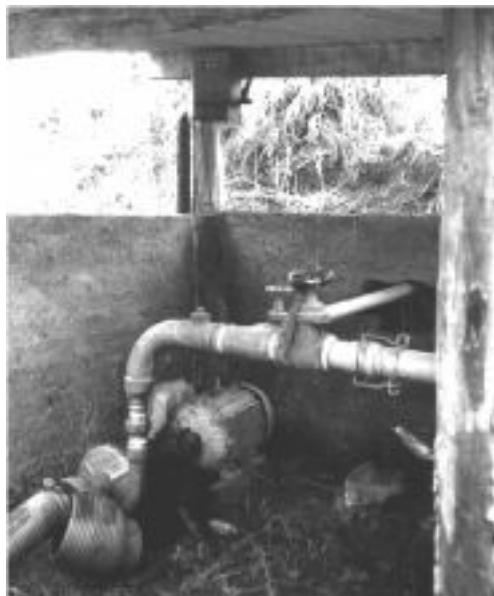
Figure 8.8: Instalação de uma motobomba de 12^{1/2} CV.
