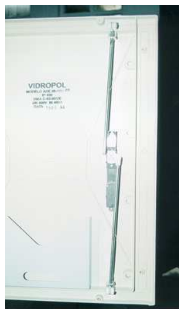
Fecho em três pontos com sistema de tranquetas
