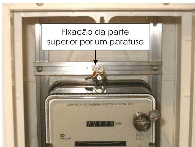
Fig. 20 – Fixação superior em calha metálica
