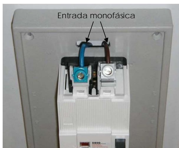
Fig. 33 – Ligação na parte superior
