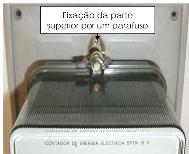
Fig. 16 – Fixação superior em prancheta
