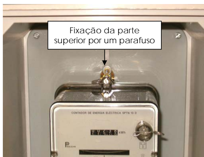
Fig. 18 – Fixação superior em placa de montagem isolante
