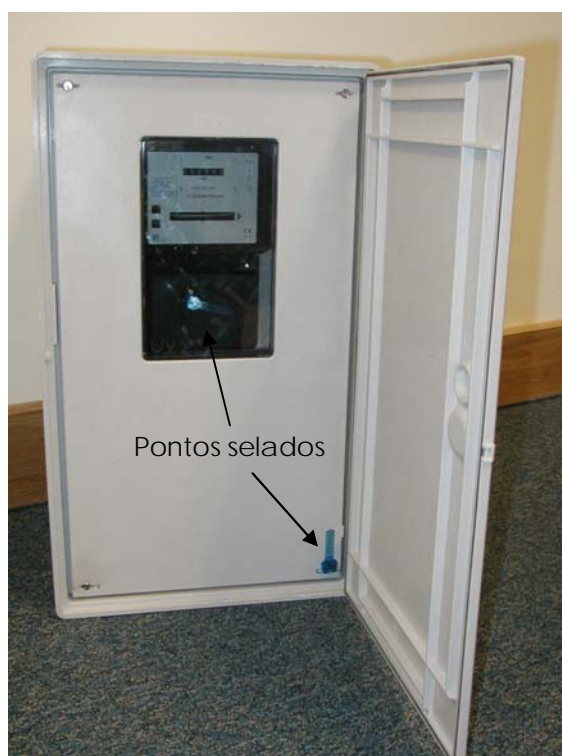
Fig. 27 – Selagem da tampa interior da caixa de contador
