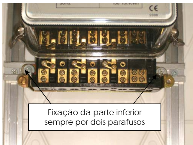
Fig. 21 – Fixação inferior em calha metálica
