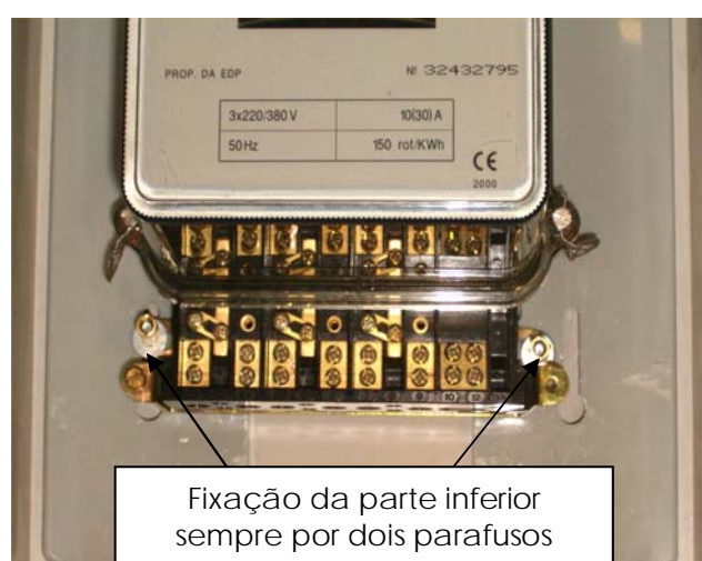
Fig. 19 – Fixação inferior em placa de montagem isolante
