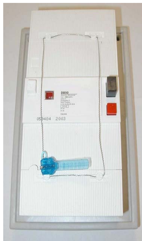
Fig. 37 – Selagem de um DCP tetrapolar diferencial
