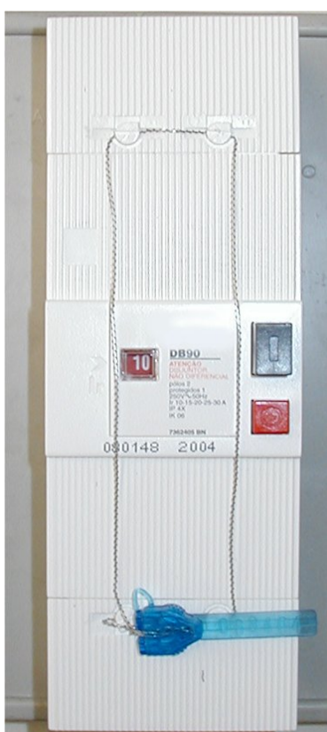
Fig. 36 – Selagem de um DCP bipolar não diferencial
