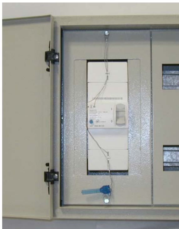
Fig. 40 – Selagem de um DCP bipolar instalado num quadro de cliente, em chapa metálica
