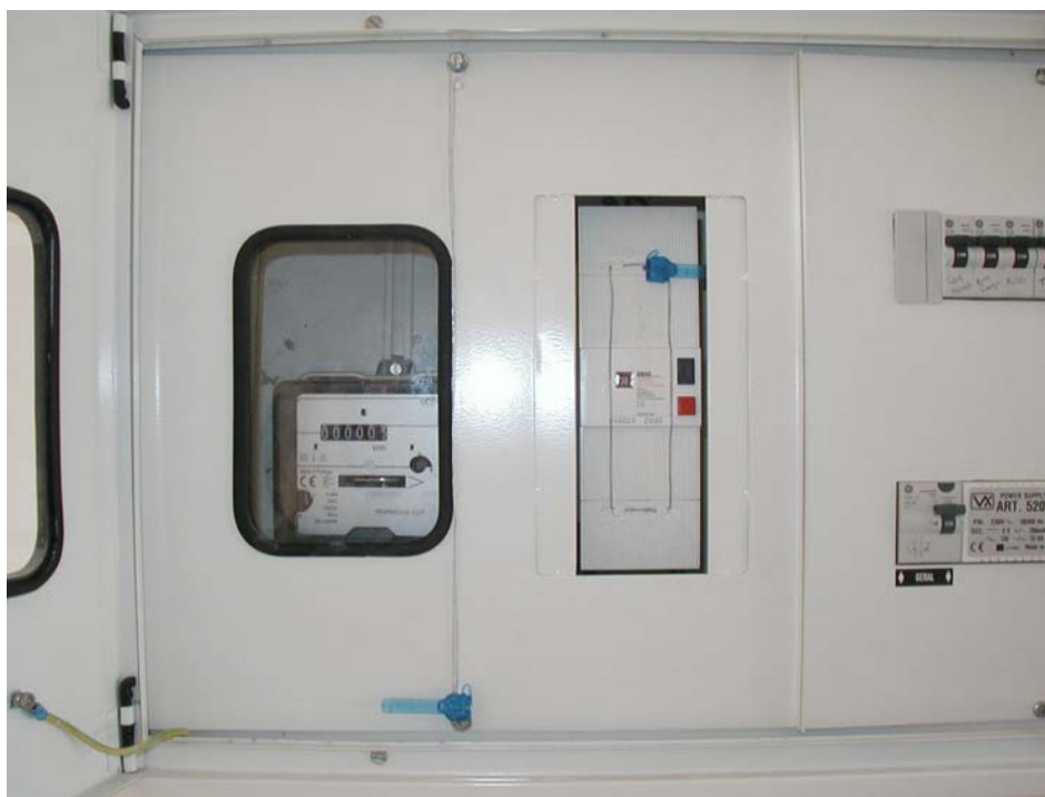
Fig. 42 – Selagem de um DCP bipolar instalado num quadro de serviços comuns, em chapa metálica
