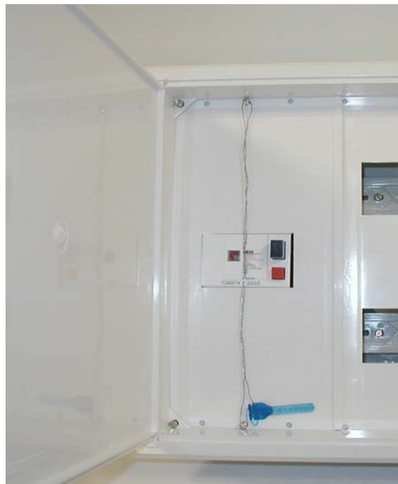
Fig. 39 – Selagem de um DCP bipolar instalado num quadro de cliente, em material isolante
