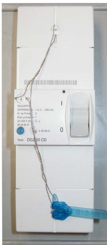
Fig. 35 – Selagem de um DCP bipolar diferencial
