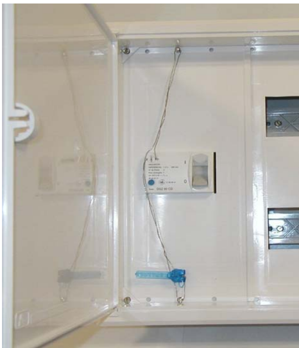
Fig. 38 – Selagem de um DCP bipolar instalado num quadro de cliente, em material isolante
