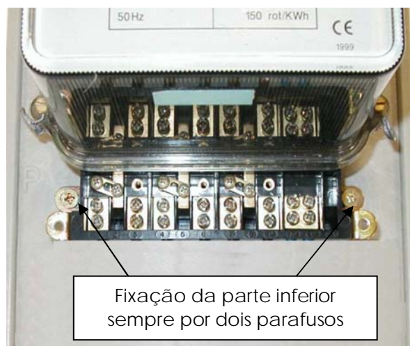
Fig. 17 – Fixação inferior em prancheta
