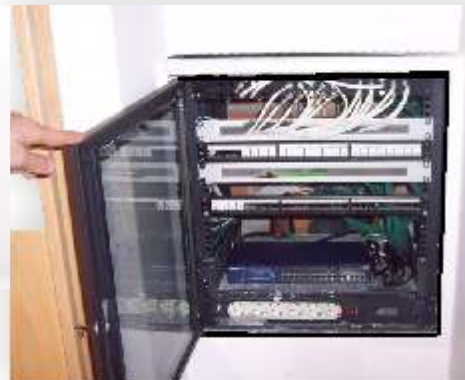
Exemplo de ATI em bastidor JSL de 9Us
