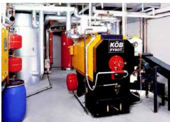
Figura 6.10 – Central de aquecimento com caldeira rotativa Gráfico: Koeb&Schaefer KG / www.koeb-schaefer.com
