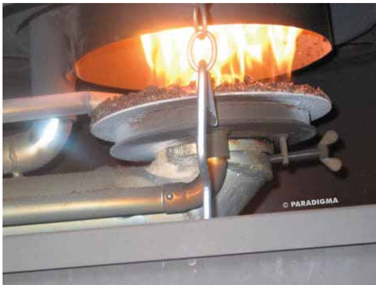
Figura 5.29 – Caldeira com sistema de alimentação inferior em operação
