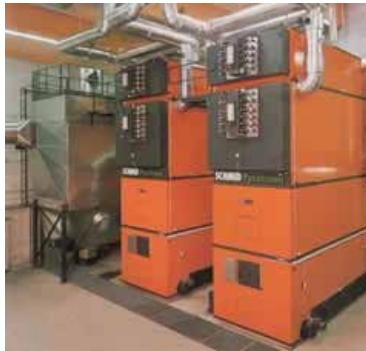
Figura 2.25 - Queimador moderno de madeira 2 x 3,2 MW
