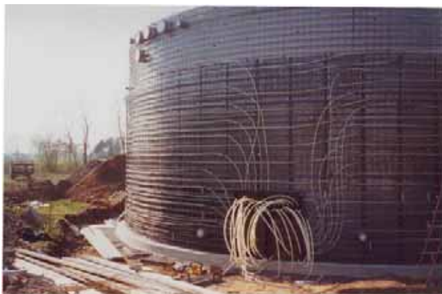
Figura 3.13 – Sistema de aquecimento do digestor
