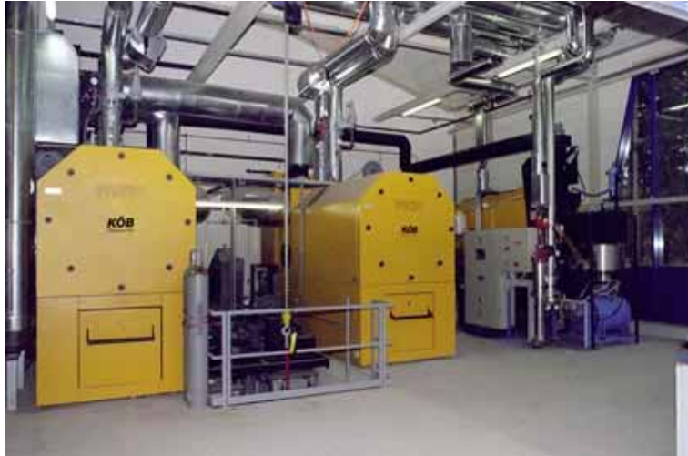
Figura 6.3 - Instalação de aquecimento central a madeira com caldeira dupla Fotografia: Koeb&Schaefer KG / www.koeb-schaefer.com
