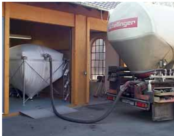
Figura 5.55 – Transferência de pellets para o silo de armazenamento
