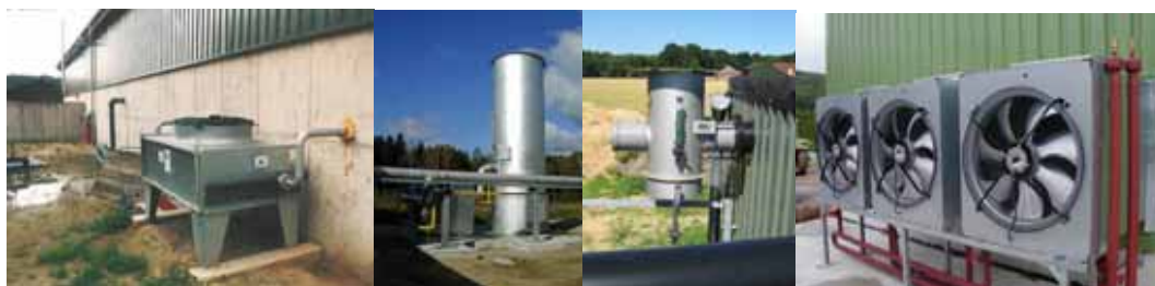
Figura 3.27 - Equipamentos de segurança (flare, válvula de segurança, etc.)
