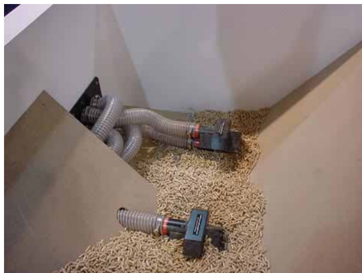
Figura 5.59 – Sistema de extracção com mangueiras no pavimento do armazém
