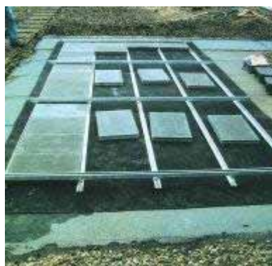
Figura 8.113 – Esquerda: Lastragem com lajes de betão inseridas em secções metálicas e Direita: Armação de metal fixada em lastros de betão
