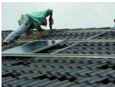
Figura 8.33 - Inserção dum modulo na secção horizontal AluTec
