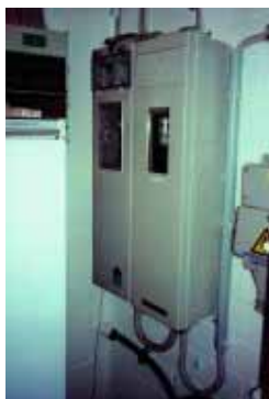
Figura 9.20 – Caixa do contador
