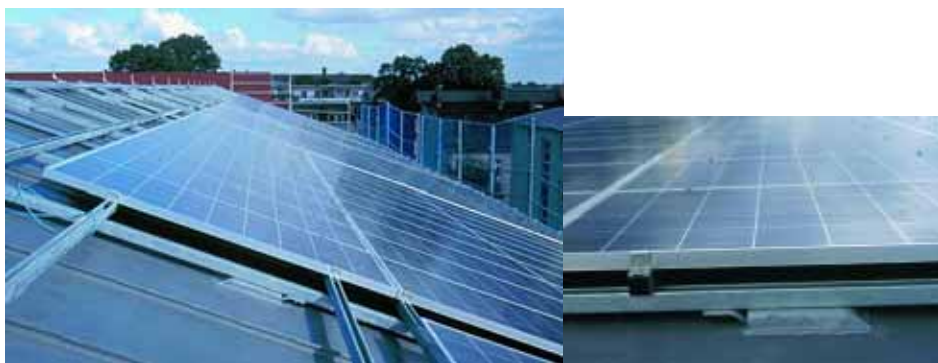
Figura 8.22 - Suporte de montagem com abertura metálica
