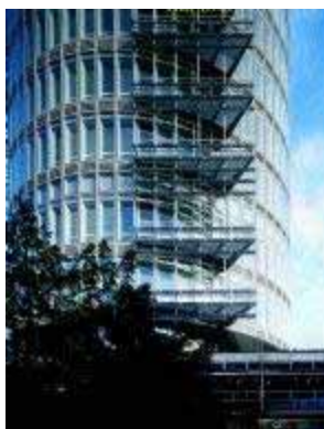
Figura 8.144 - Fachada de duplo revestimento folha: Sparkass 2000 em Pforzheim, Alemanha.
