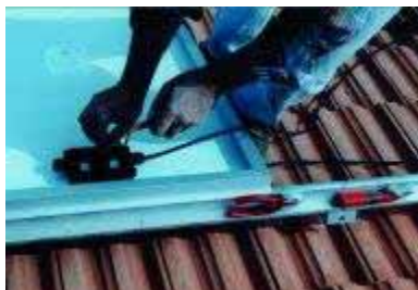
Figura 9.14 – Ligação dos módulos
