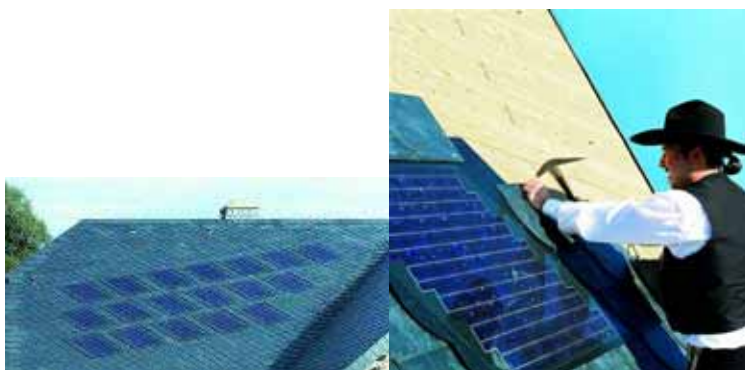
Figura 8.71 - Colocação e vista final das telhas SolarSklent
