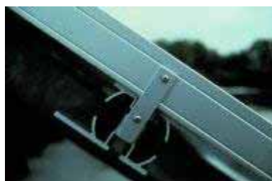
Figura 8.31 - Grampo entre dois módulos com armação
