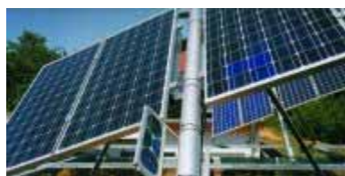
Figura 2.37 - Sistema de orientação solar com controlo eléctrico
