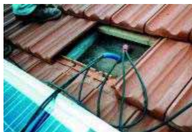
Figura 9.17 – Abertura no telhado para a passagem dos cabos das fileiras
