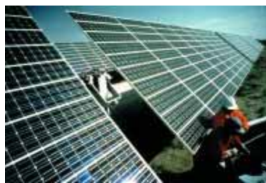
Figura 2.18 -Sistema fotovoltaico com ligação à rede, encontrando-se a instalação fixada no solo Imagem: Siemens
