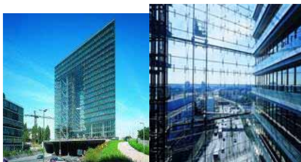
Figura 8.145 - Átrio do edifício “Stadttor” de Dusseldorf, Alemanha Envidraçado suspenso com sistema de fixações pontuais Estrutura: Ove Arup e Partners/Lavis Stahlbau Offenbach Fotografias: Werkfoto Gartner
