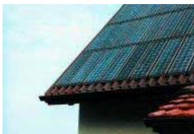
Figura 8.63: Módulos colados em placas trapezoidais Fotografia: PMS Energie AG
