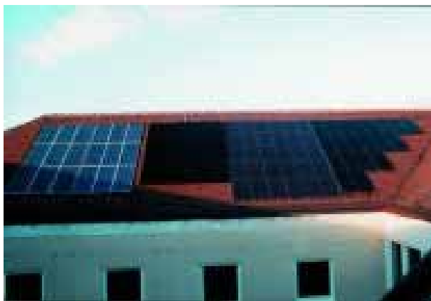
Figura 2.92 - Instalação fotovoltaica com módulos que utilizam várias tecnologias de células solares no Colégio Weißenstephan (Alemanha). Da esquerda para a direita: policristalino, monocristalino, CIS, amorfo, Telurieto de Cádmio, sendo cada um de aprox. 1 kWp
