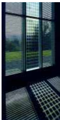
Figura 3.41 - Efeito de luz e de sombra provocado pelas células (janelas envidraçadas da esquerda e da direita). Os envidraçados do centro são módulos de vidro isolante com células solares POWER integradas Imagem: Solon AG, Zwickert
