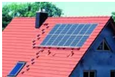
Figura 2.16 – Sistema fotovoltaico ligado à rede, instalado no telhado de uma casa familiar Imagem: ENERGIEBISS
