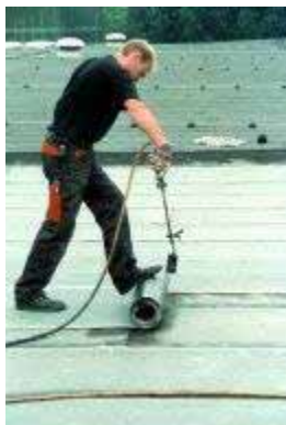
Figura 8.9 - Assentamento da membrana betuminosa
