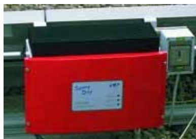
Figura 3.91 - Inversor de cadeia de módulos
