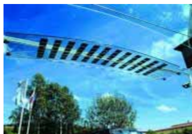
Figura 3.21 - Módulo específicos de vidro curvo O módulo vidro-vidro (resina fundida) curvado em frio é mantido em tensão através de tirantes Fotografia: Saint Gobain
