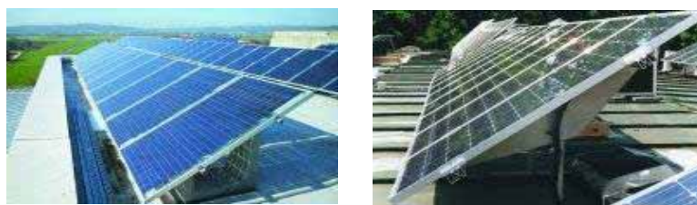
Figura 8.114 – Esquerda: Sistema de fixação em pedra, em L e Direita: Suporte ajustável, para as posições do Inverno e do Verão
