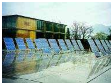
Figura 8.111 - Montagem sobre placas de betão
