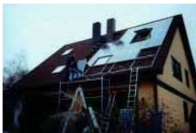
Figura 9.15 – Inserção dos módulos
