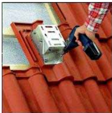
Figura 8.26 - Telha de fixação de alumínio
