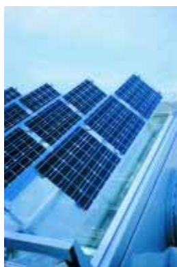
Figura 3.33 - Módulos semitransparentes para protecção solar no telhado em forma de dente de serra de uma casa particular (Jakob-Kaiser-Haus) em Berlim, Alemanha Módulos vidro-Tedlar: Sólón
