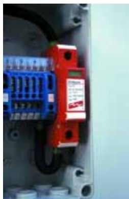
Figura 5.27 - Descarregador de sobretensões
