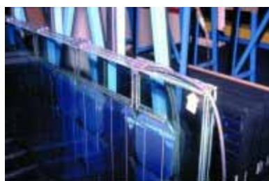
Figura 3.47 - Saída dos cabos ao longo do rebordo do vidro
