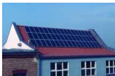
Figura 2.17 – Sistema fotovoltaico com ligação à rede numa área urbana, na zona comercial de Weierwirtschaft em Berlin
