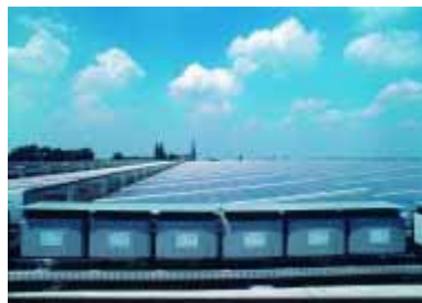
Figura 5.8 - Inversores de fileira de módulos ao longo do sistema fotovoltaico de Herne Fotografia: Flabeg
