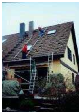
Figura 9.8 – Instalação dos ganchos do telhado
