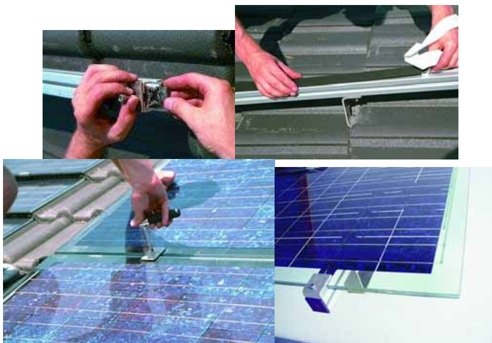
Figura 8.39 - Sequência da montagem Fotografias: Abakus
