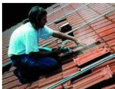
Figura 9.10 – Recorte das telhas
