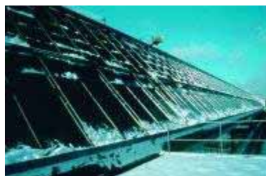
Figura 4.2 - Neve num sistema fotovoltaico Fotografia – Energiebiss
