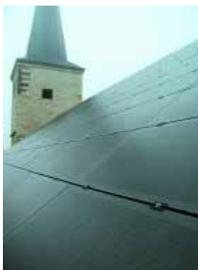
Figura 3.32 - Módulos vidro-película com contactos frontais pretos e película posterior preta de polyester Tedlar, na igreja de Riethnordhausen perto de Erfurt, na Alemanha (classificado como monumento histórico)
