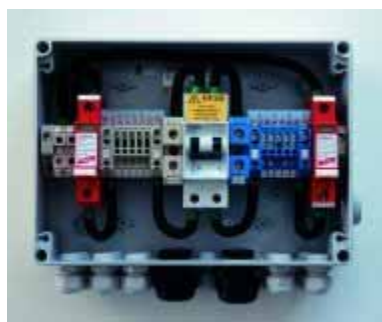
Figura 3.78 - Caixa de junção do gerador
