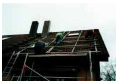
Figura 9.12 – Fixação das secções horizontais
