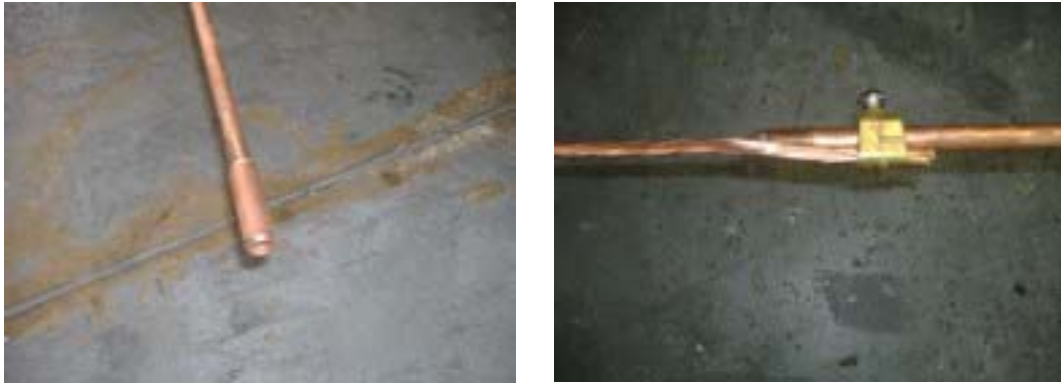
Figura 3 – Eléctrodo de terra com as dimensões de 2,1 m de comprimento e 16mm de diâmetro.
