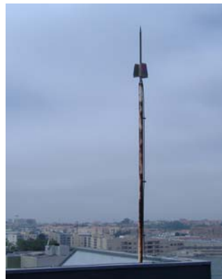
Figura 8 – Pára-raios acoplado em torre
